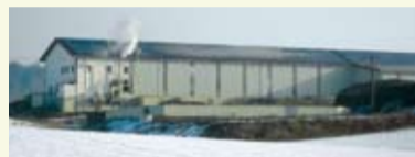
Biogasanlage mit 1.100 KW
